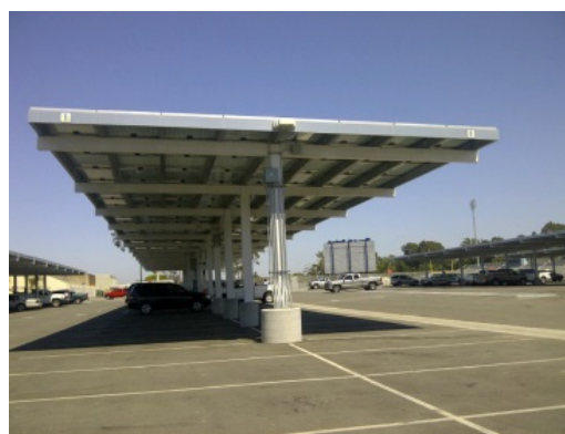
PV Solar Canopy
