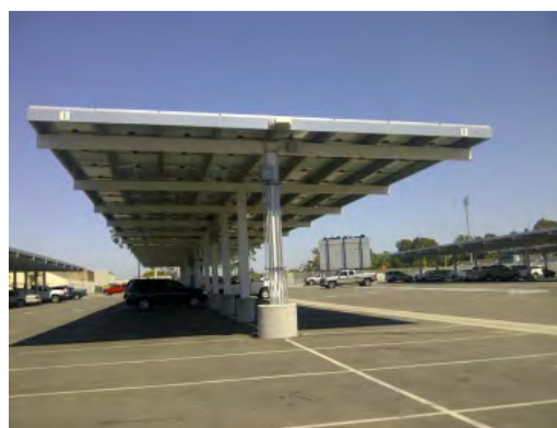
PV Solar Canopy
